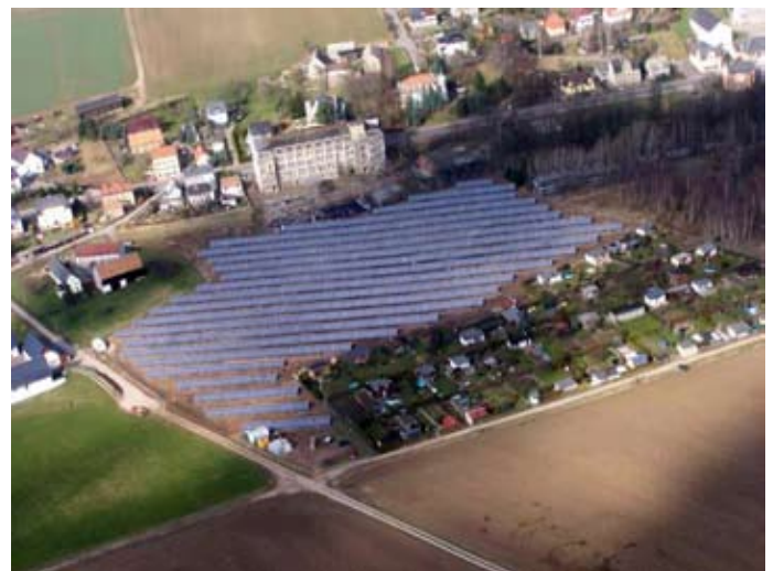
PV Kraftwerk Claussnitz
